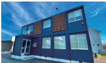
現在は民設公営型の施設「起業家支援センター」で活動を行っている
